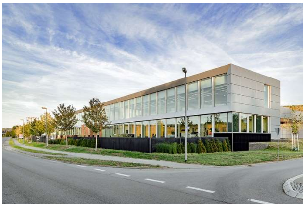
Die ZELTWANGER Maschinenbau GmbH in der Tübinger Eisenbahnstraße
